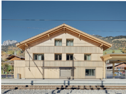
Aufnahmegebäude BLS Bahnhof Erlenbach
