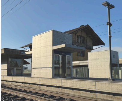
Perrondach SBB Bahnhof Uttigen
