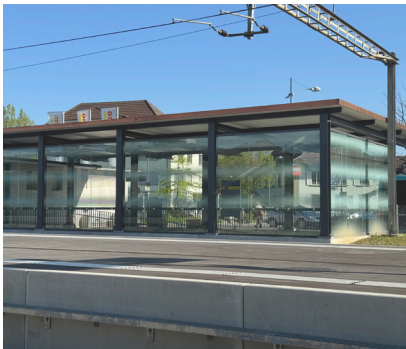
Neue Verglasung Unterführung SBB Bahnhof Brugg
