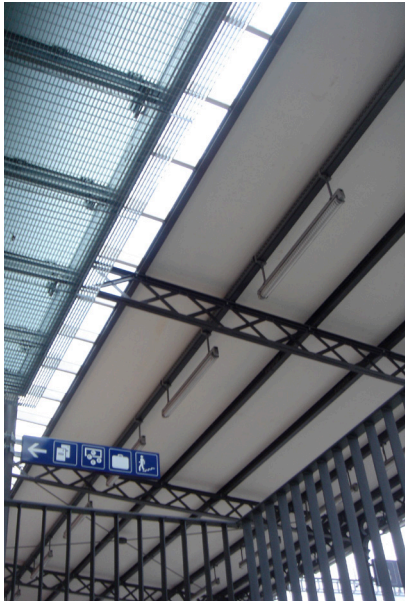
Natürliches Licht in der PU durch abgestuftes Glasbausteindach
