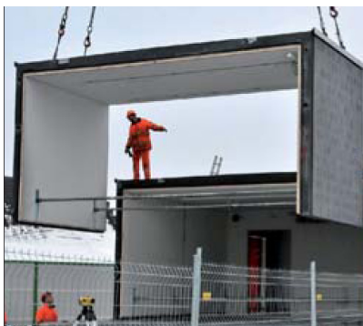
Neubau Fertigelementbau Betriebstechnikgebäude Brücke Scheibenstrasse
