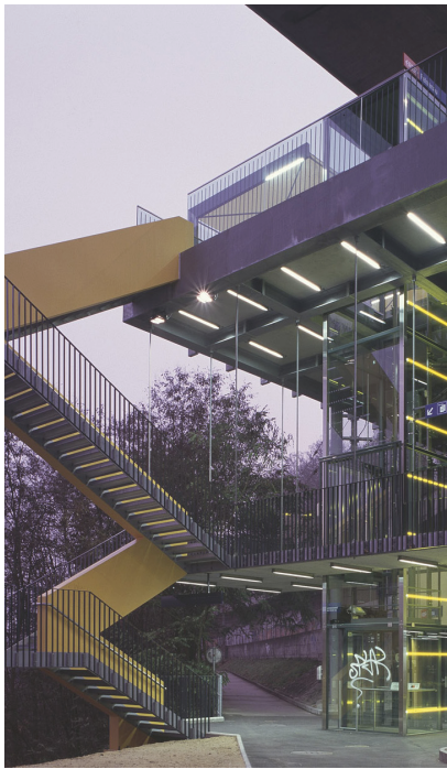
RBS Station Felsenau Nachtaufnahme
