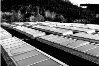
flache Oblichtbänder mit Lüftungsfügel
