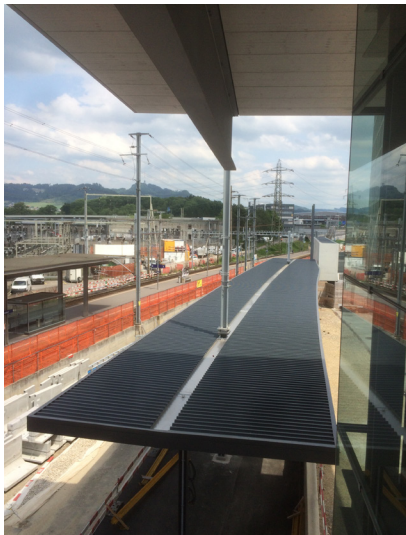
Neues Perrondach Ansicht aus Passarelle
