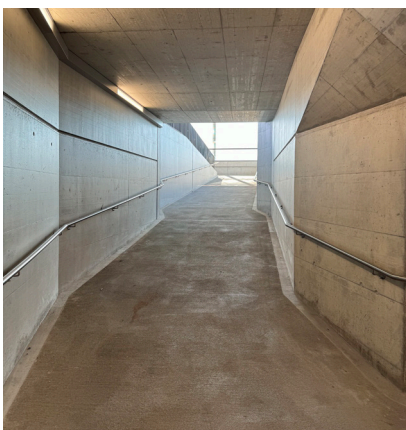
Unterführung SBB Bahnhof Brugg
