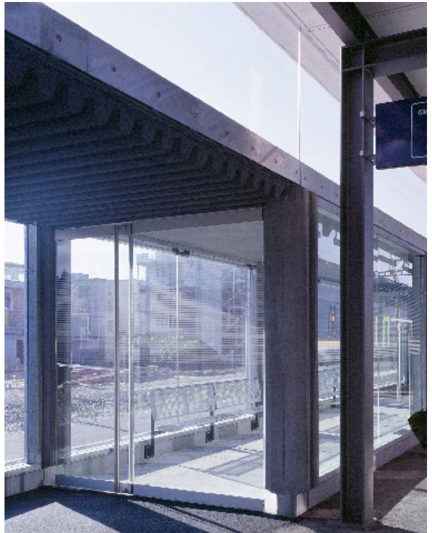
Aussenperrondach und Lärmschutzwand Bahnhof Rubigen
