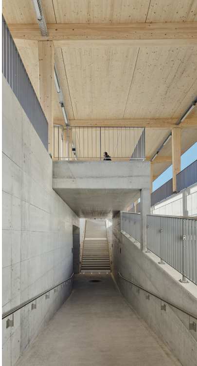
Unterführung BLS Bahnhof Erlenbach
