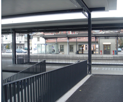
Sanierung Postgebäude, mit beidseitiger Verglasung, Durchgang und Metallbeleuchtungsdecke
