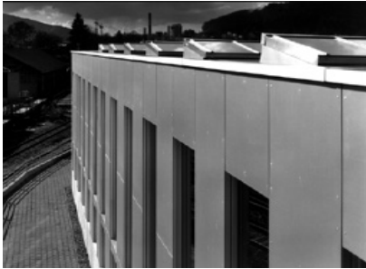
Fassade mit grossformatigen Etemitplatten und Oblichtern
