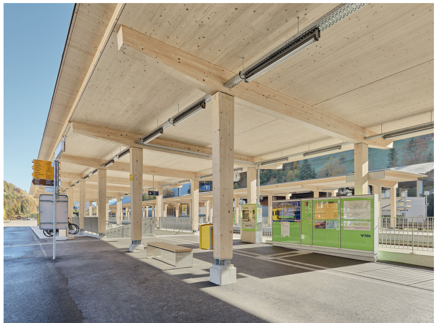
Perrondach BLS Bahnhof Erlenbach
