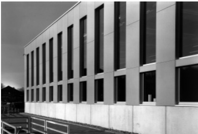
Fassade mit grossformatigen Etemitplatten und Oblichtern
