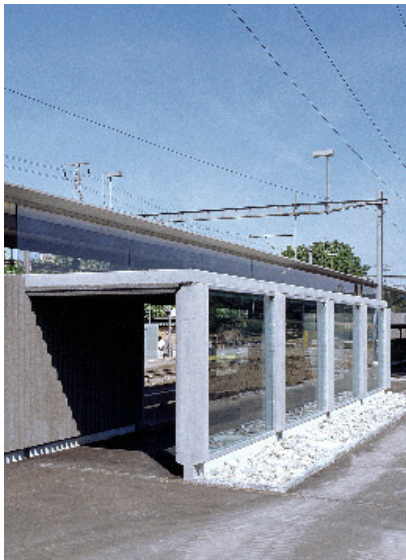
Lärmschutzwand mit Eingang auf Aussenperron SBB
