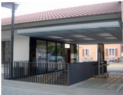
Natürliches Licht in der PU durch abgestuftes Glasbausteindach
