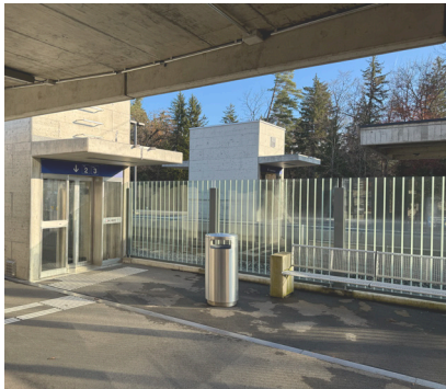
Perrondach SBB Bahnhof Uttigen
