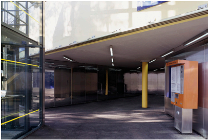
Neubau RBS Station Felsenau Bern Unterführung
