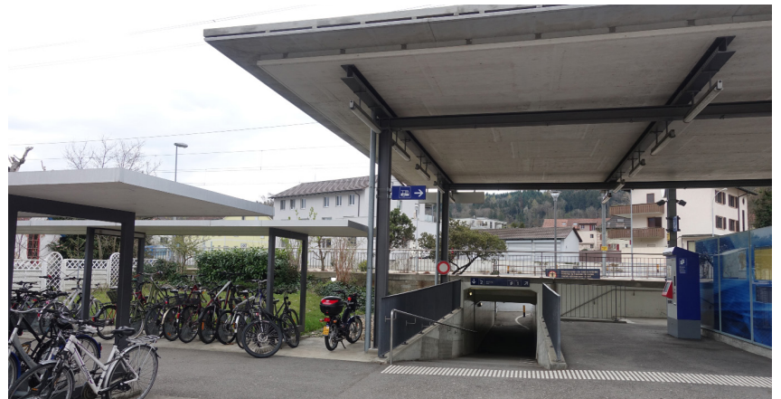
Zugang mit Kundencenterdach und Velodächer
