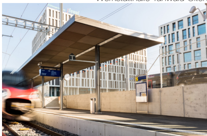
Bahnhof Wankdorf Neues Hausperron mit Überdachung
