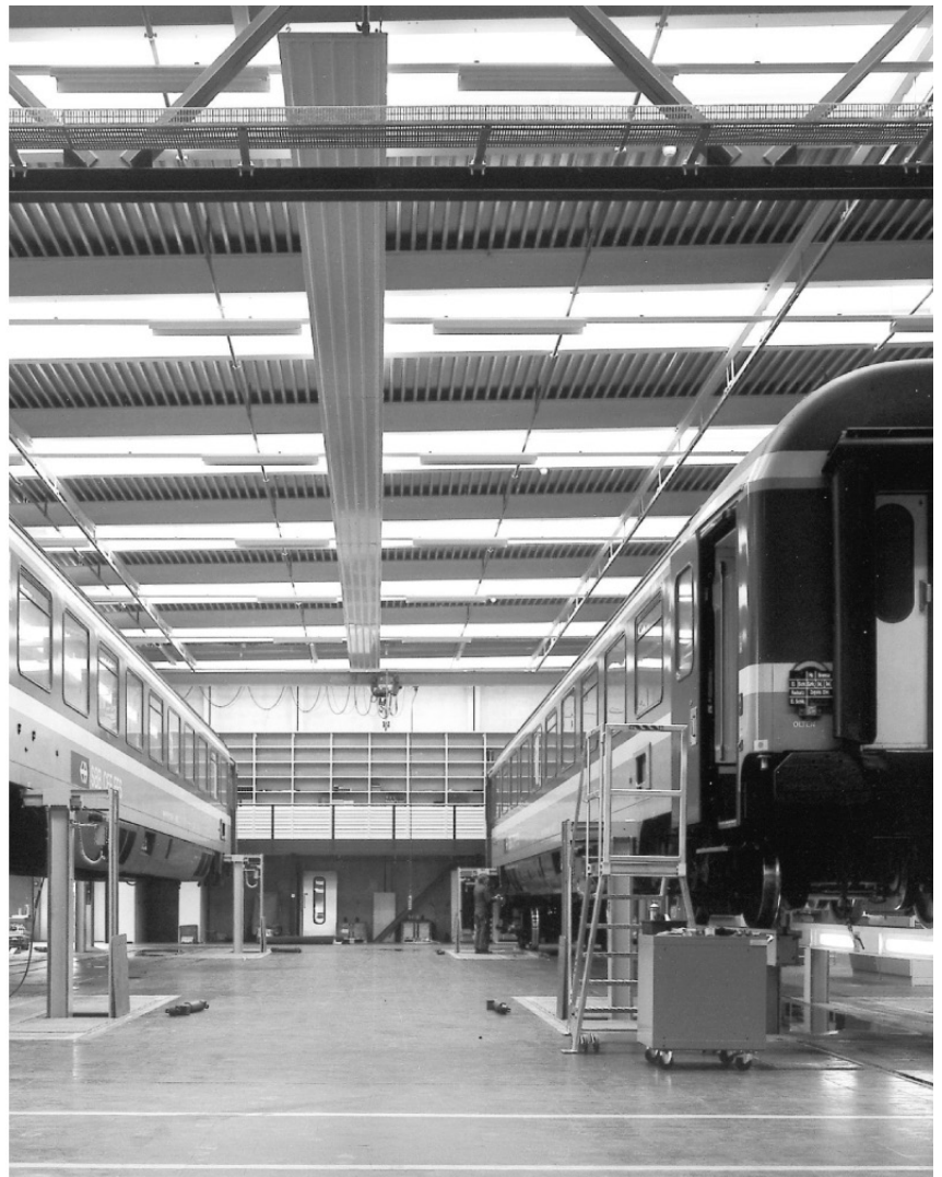
Werkstatthalle Innenraum Dachaufsicht Erweiterung
