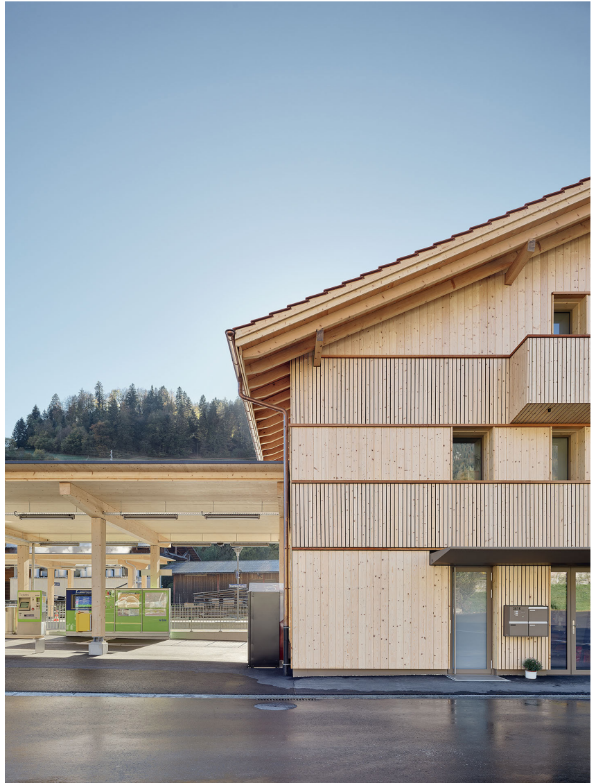
Gesamtansicht BLS Bahnhof Erlenbach
