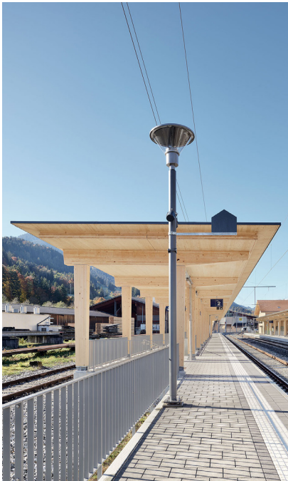
Perrondach BLS Bahnhof Erlenbach
