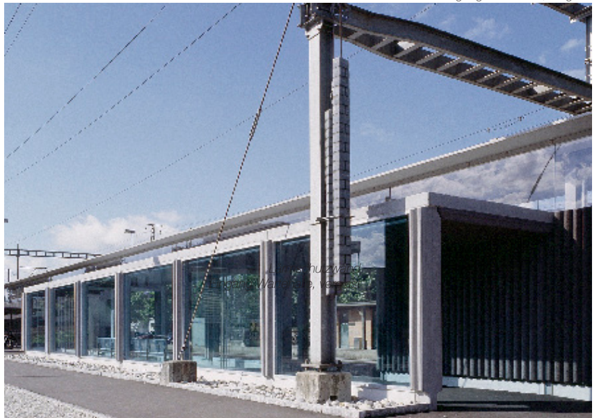
Lärmschutzwand Eingang Wartehalle, verglast
