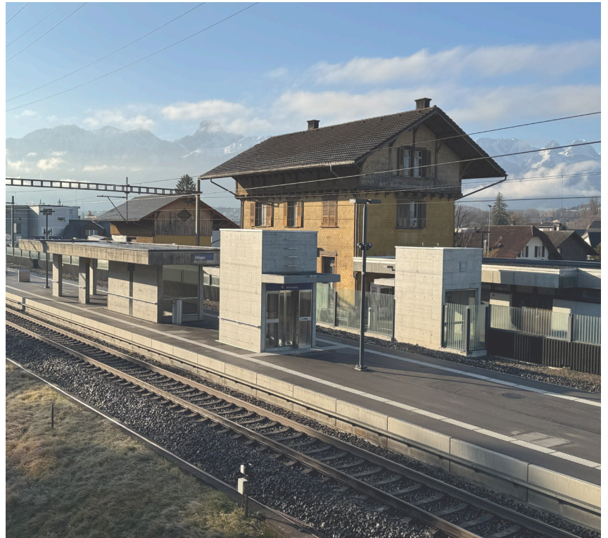
Perrondach SBB Bahnhof Uttigen
