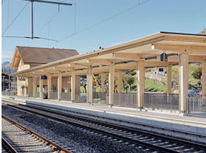
Ansicht Aufnahmegebäude Hausperron
