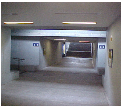
Neue zentrale Personenunterführung Glasbausteine zur Belichtung
