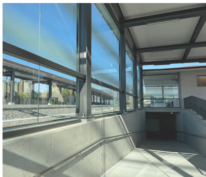
Rampe Unterführung SBB Bahnhof Brugg
