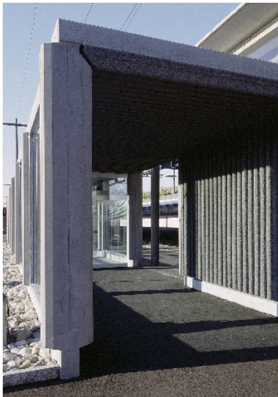
Lärmschutzwand mit Eingang auf Aussenperron SBB
