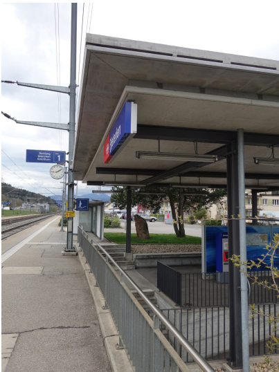
SBB Bahnhof Pieterlen Ansicht Perron
