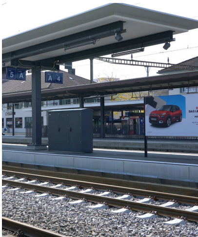
z. B. Bahnhof Lyss BZU23 und neues Normperrondach
