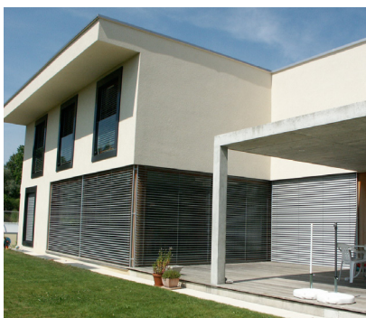
Einfamilienhaus Vorackerrain Gümliigen Gartenansicht mit Gartenpavillon
