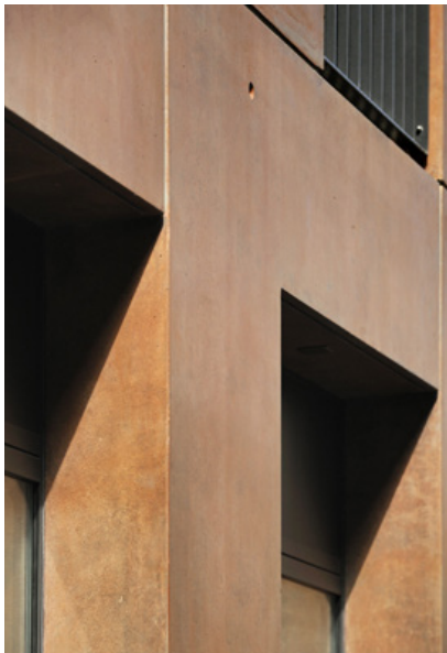
Façade Rue Du-Bois-Melly
