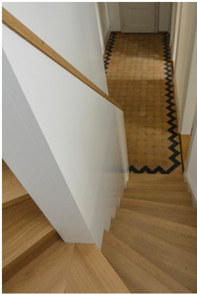
Maisonettewohnung Erd- und Obergeschoss Neue Verbindungstreppe
