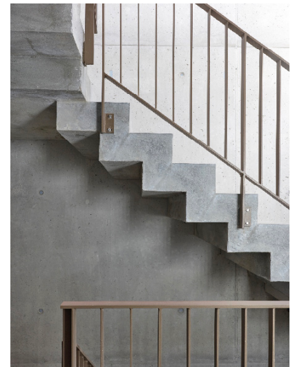
Erweiterung Güterstrasse 22 Bern Treppenhaus
