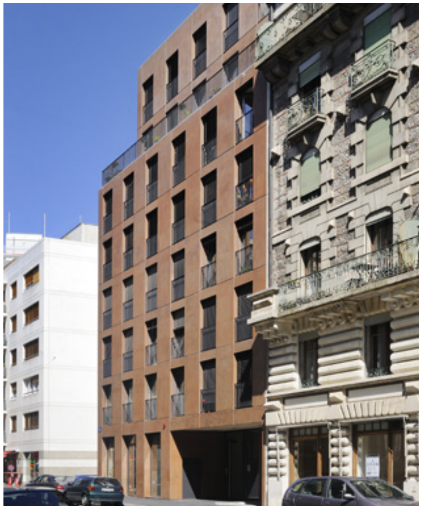
Façade Rue Du-Bois-Melly
