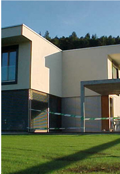
Einfamilienhaus Vorackerrain Gümliigen
