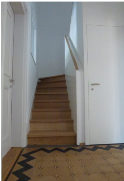
Maisonettewohnung Erd- und Obergeschoss Neue Verbindungstreppe
