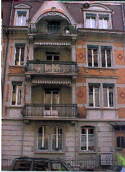
Kasernenstrasse 16 Bern Sanierung Küchen und Bäder, Dachausbau
