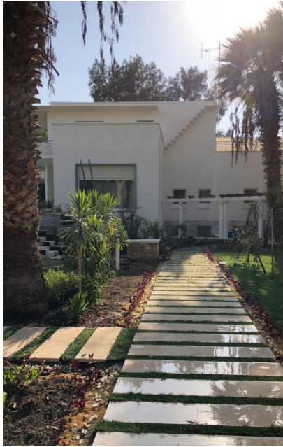
Restaurierung Steinarbeiten / Garten
