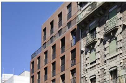
Projektierung & Realisierung Immeuble locatif Rue Du-Bois-Melly Genève
