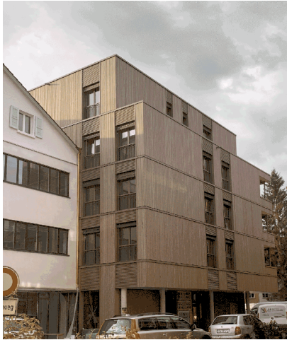
Erweiterung Güterstrasse 22 Bern Alt- und Neubau
