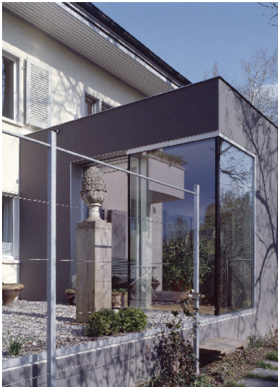
Umbau/Anbau Villa Mettlenhölzliweg Muri
