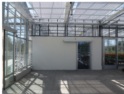
Innenansicht Gewächshaus Technikraum
