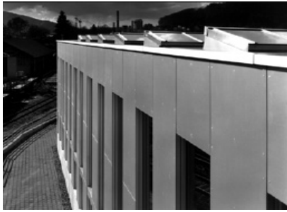
Fassade mit grossformatigen Eternitplatten und Oblichtern
