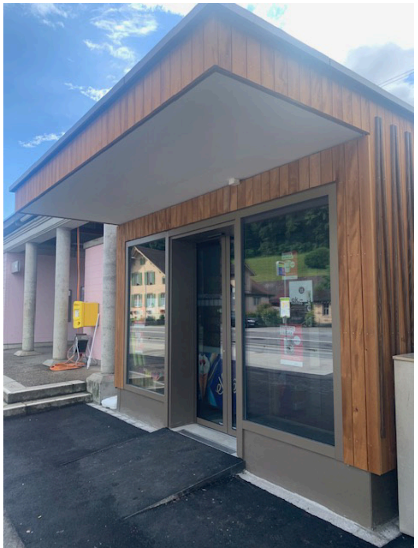
Neubau Kioskgebäude Bahnhof Wynigen Gesamtansicht
