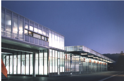
Neubau Werkhof Ostermundigen Vorderfassade mit Zugangstreppe
