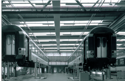
Neubau SBB Werkstatthalle HW Olten Innenansicht
