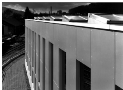
Fassade mit grossformatigen Eternitplatten und Oblichtern
