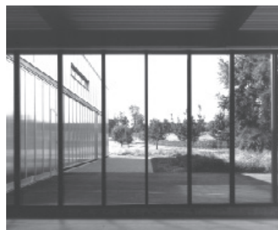
Tordurchfahrt zur rückwertigen Halle Schiebetor
