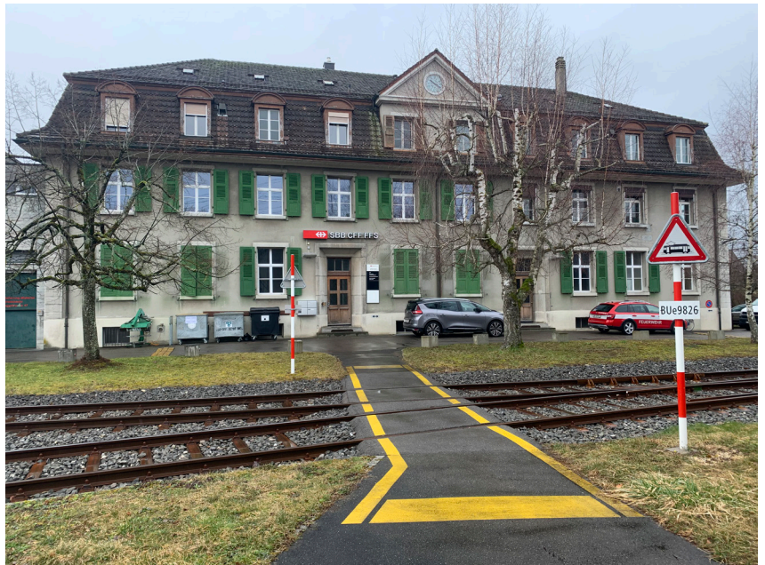
SBB Depotdienstgebäude Biel Gesamtansicht
