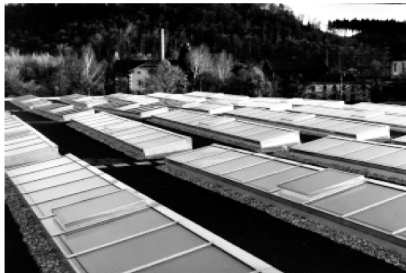
flache Oblichtbänder mit Lüftungsflügel
