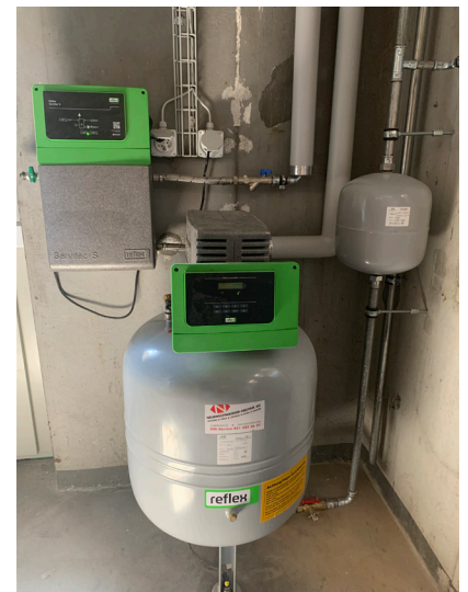
Heizungersatz Neue Pelletheizung
