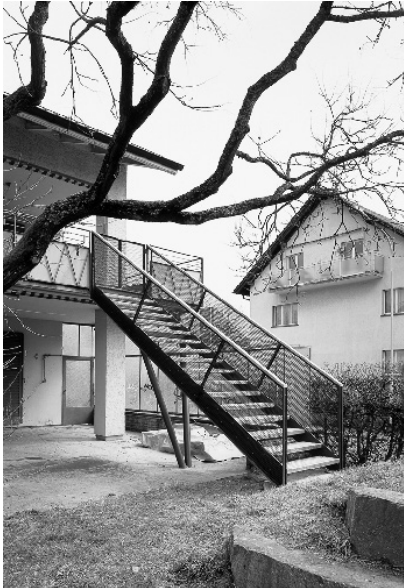
Aussentreppe zu Wohngruppe 1.OG
